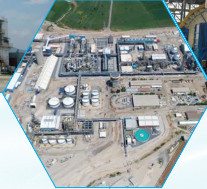
Mardin Mazıdağı Metal Geri Kazanım ve Entegre Gübre Tesisleri Projesi
